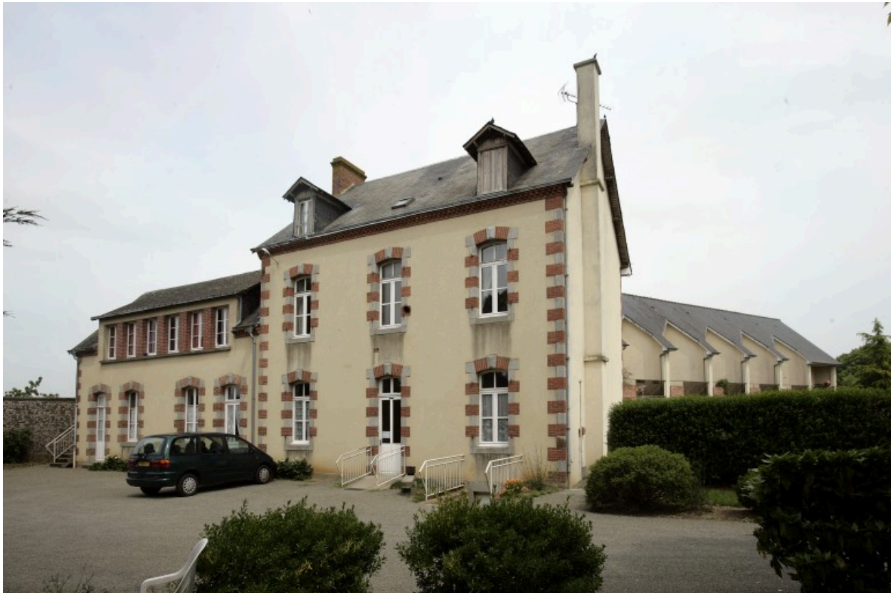
Vue d'ensemble depuis la cour à l'ouest.
