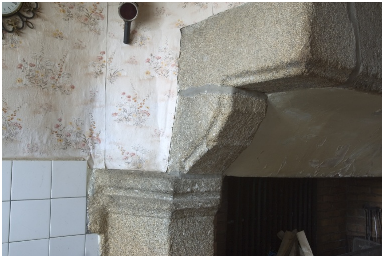
Intérieur du logis, rez-de-chaussée, salle principale : le corbeau gauche de la cheminée.
