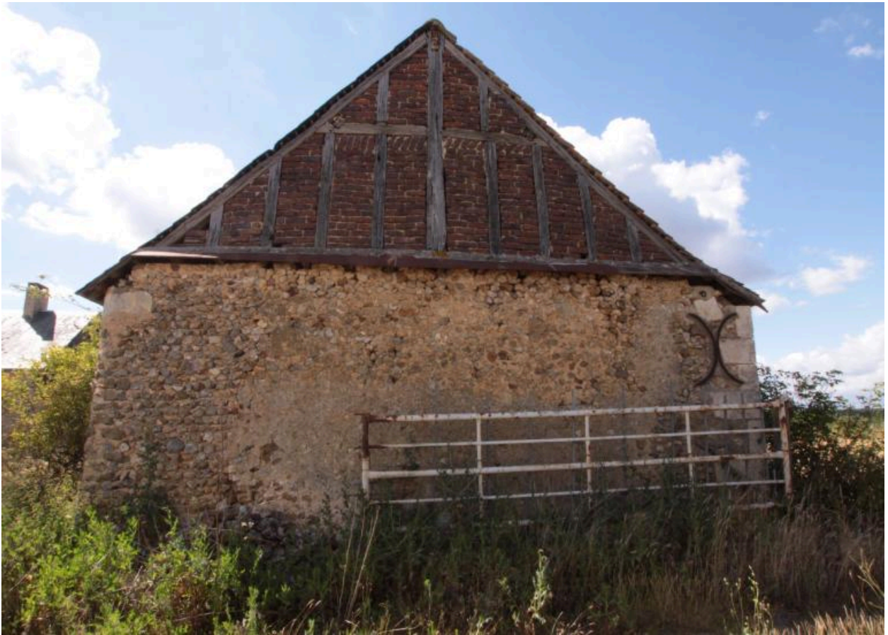
Grange 1 : mur-pignon fermé par des planches.
