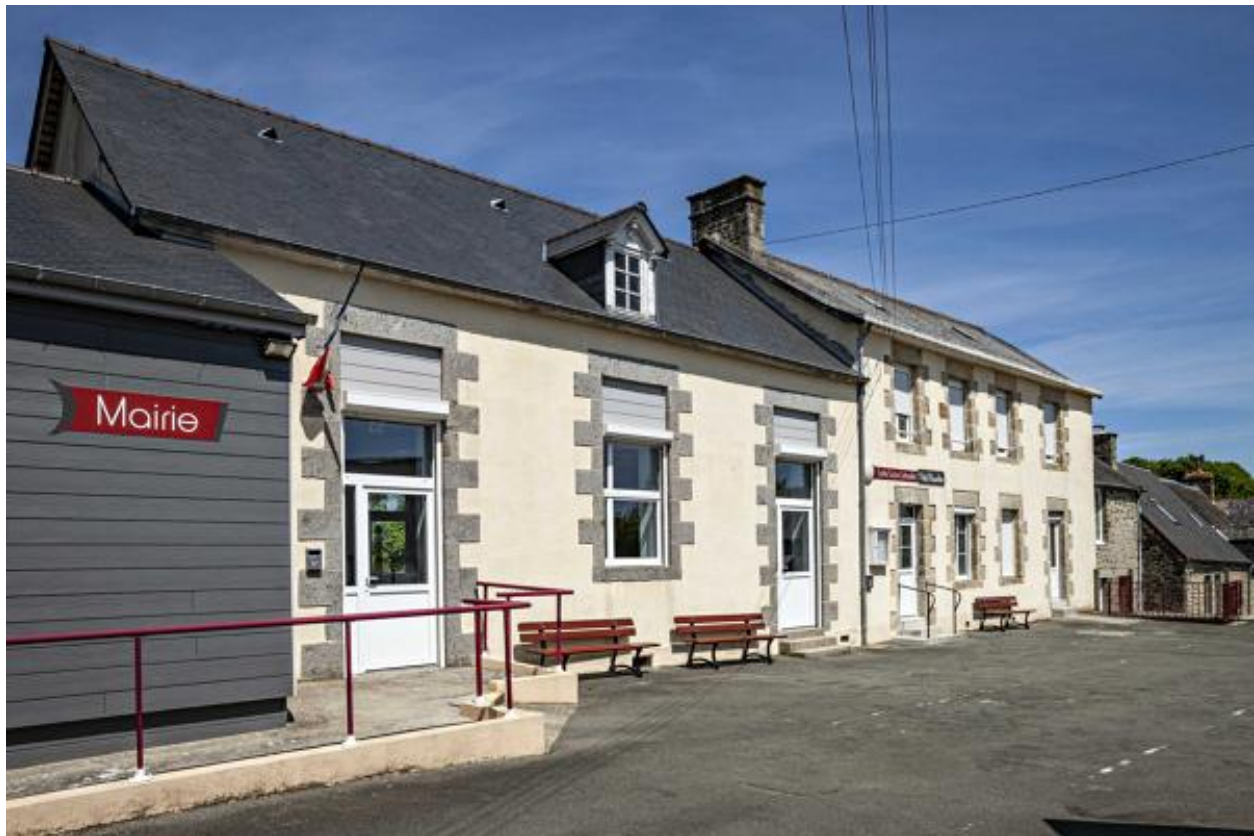
Mairie et ancienne école de garçons de Sainte-Marie-du-Bois.
