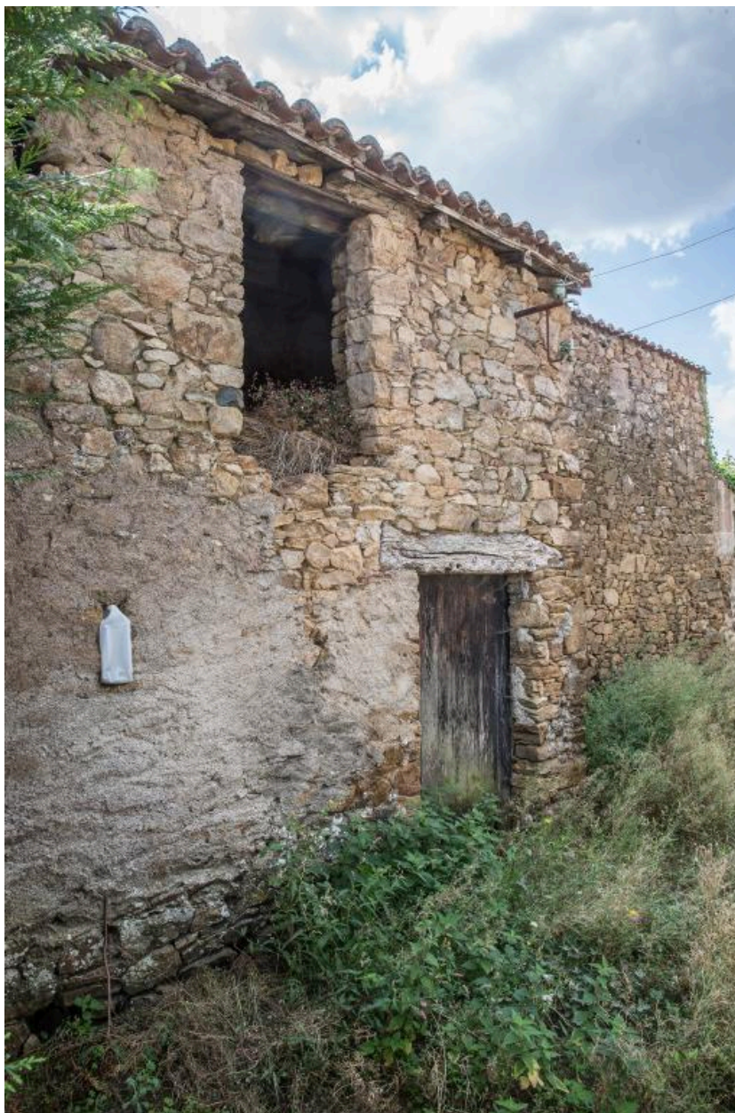
Etable dotée d'un comble à surcroît servant de fenil. La Barillère, Mouzillon, cadastre 2018, AT 01-175.
