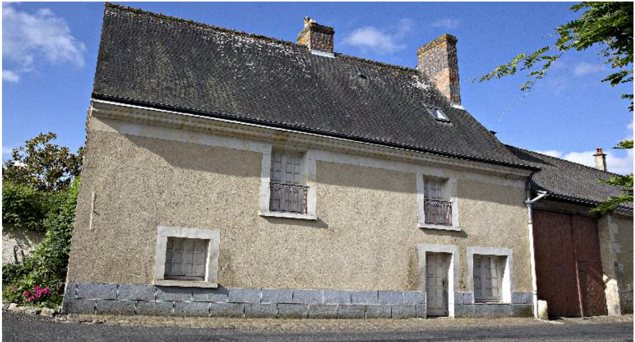
Façade postérieure sur rue.
