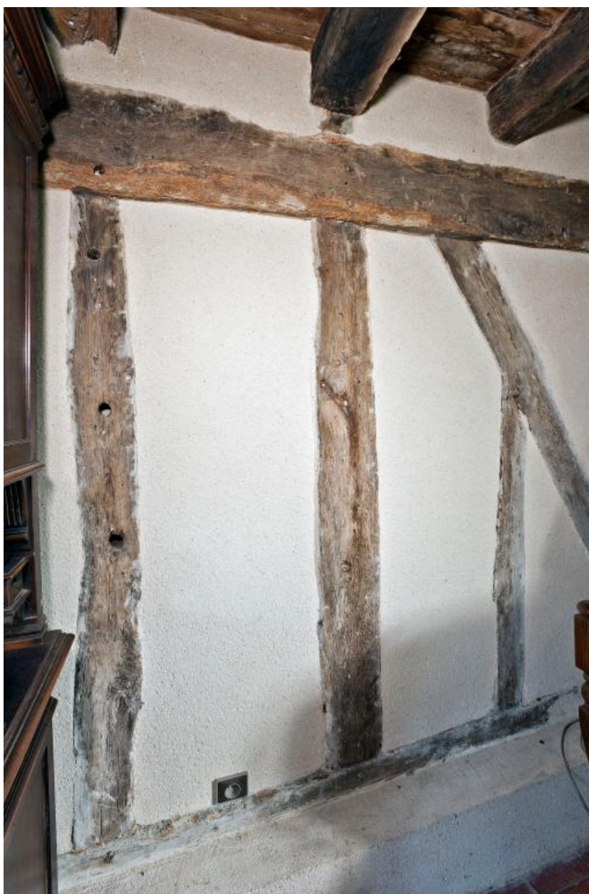
Chambre à feu est, cloison : détail du pan de bois.
