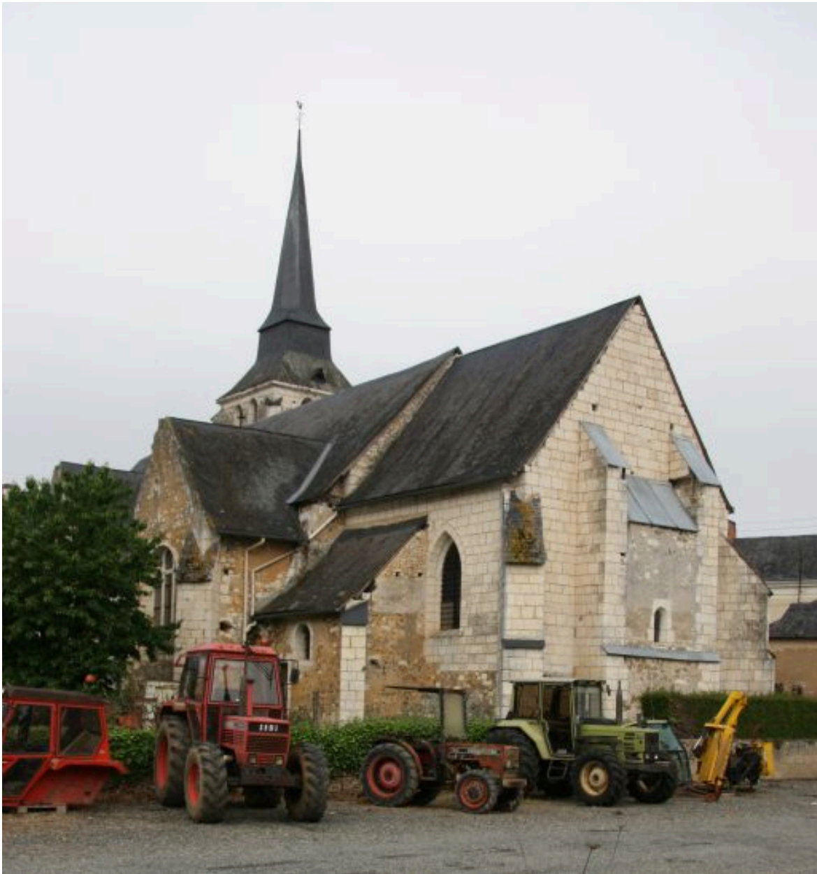
Vue de volume prise du sud-est.
