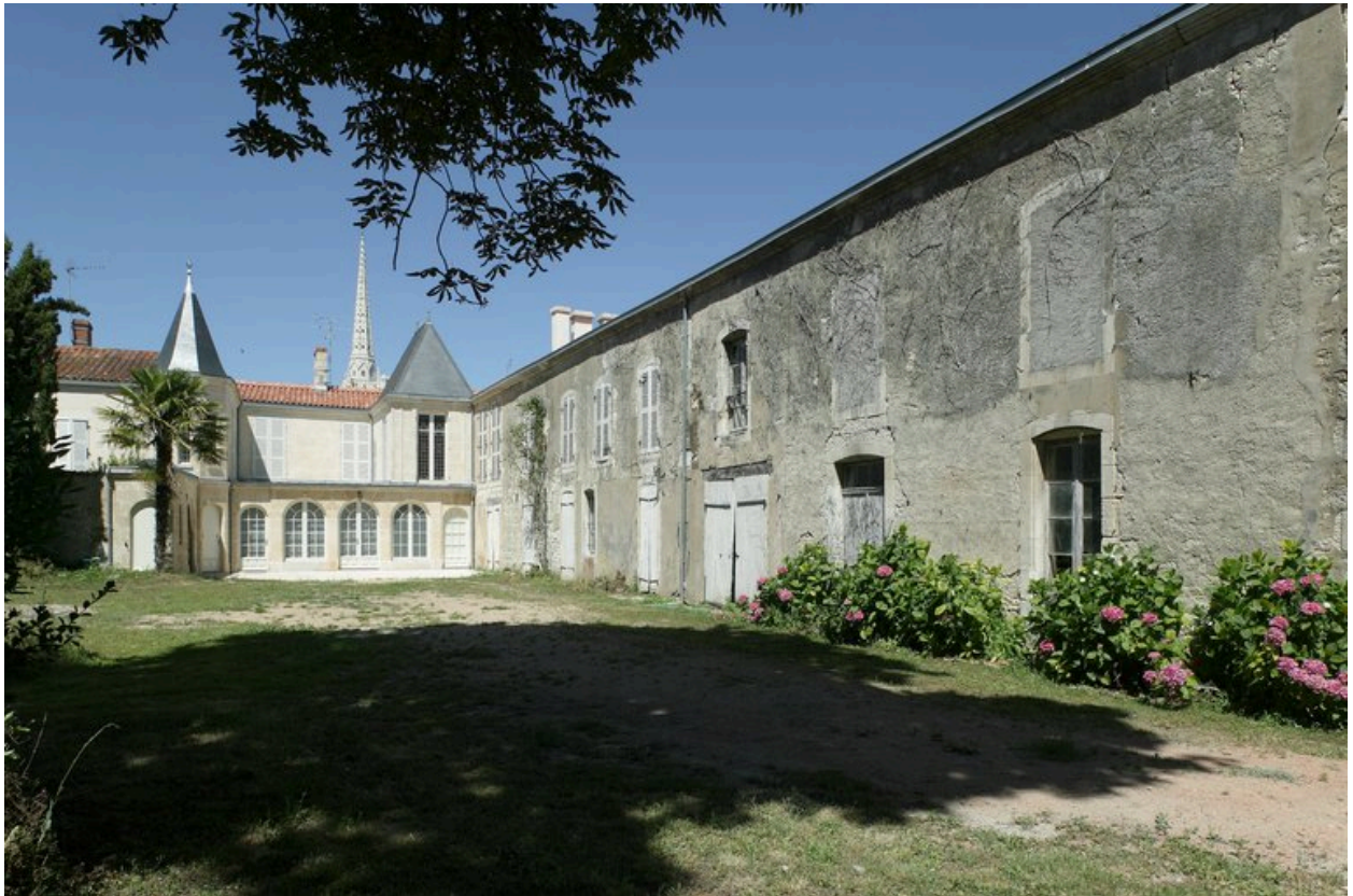
Façades donnant sur le jardin (vue d'ensemble prise du sud).
