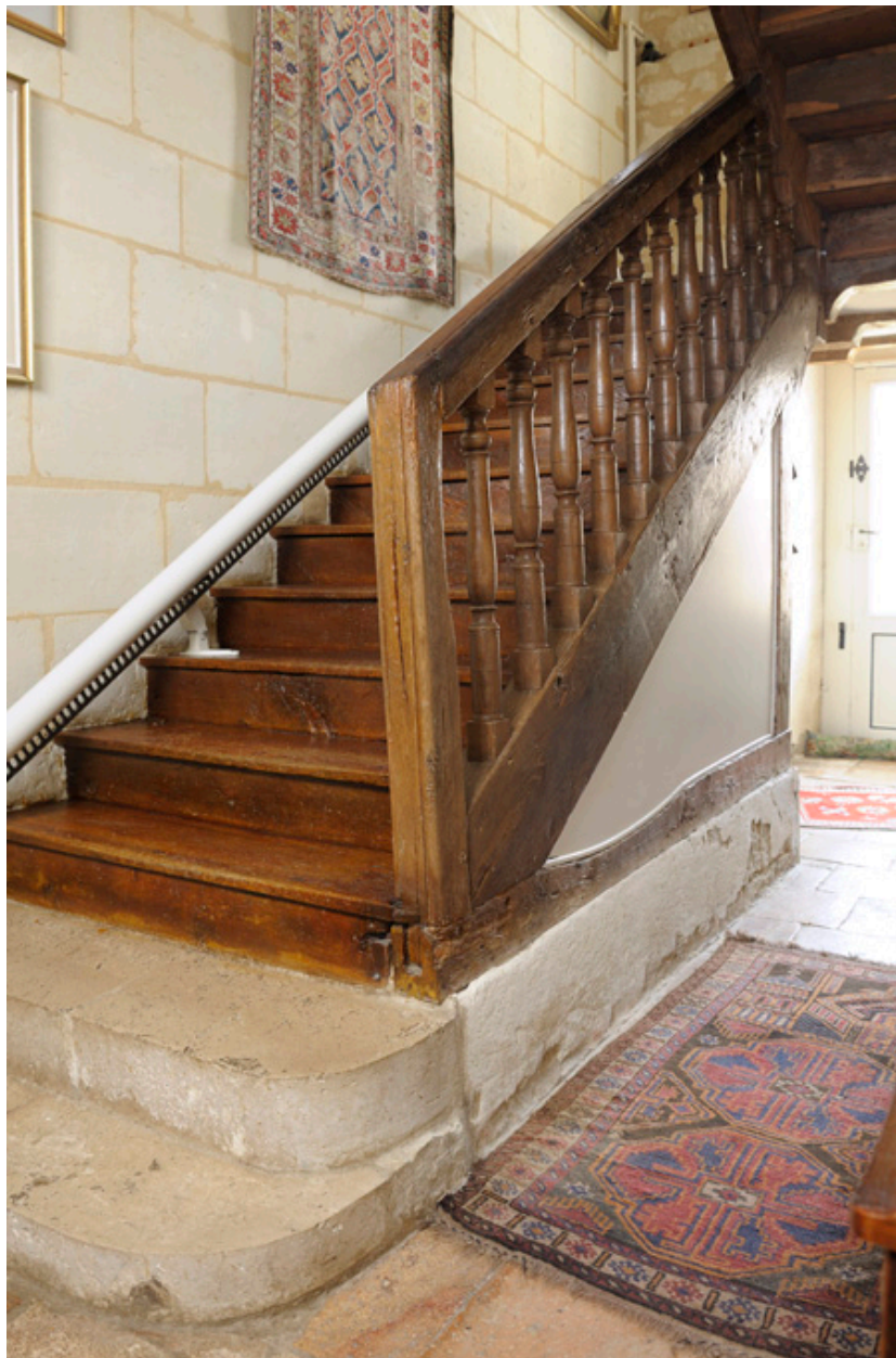
Escalier : détail des balustres.
