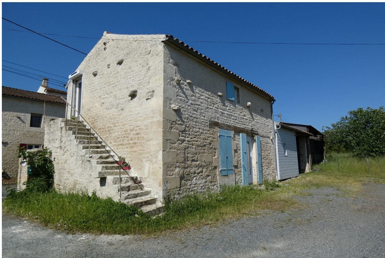
L'habitation avec escalier extérieur, vue depuis l'est.
