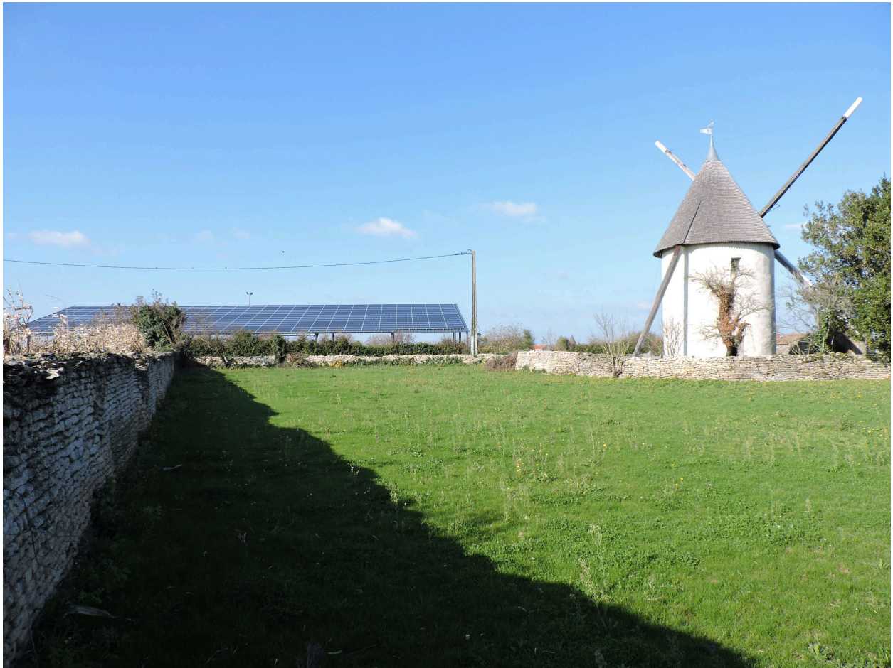
Le clos de mur au sud et à l'ouest de l'ensemble, vu depuis le sud-est.
