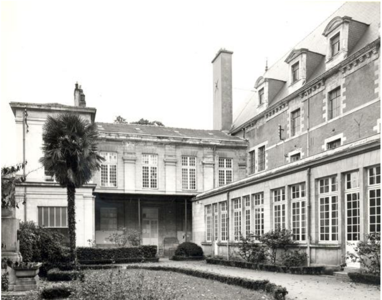
Aile nord du cloître, façade postérieure nord et bâtiment sur la cour "des Arts-et-Métiers".
