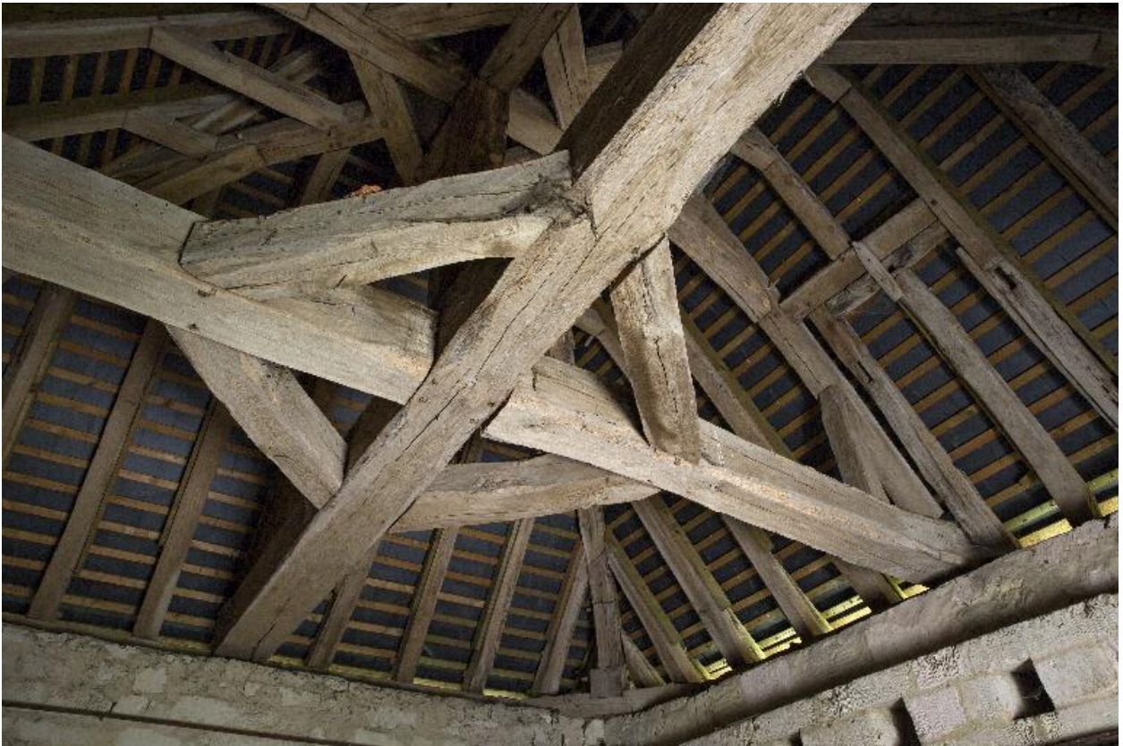
Le pigeonnier : détail de la charpente.
