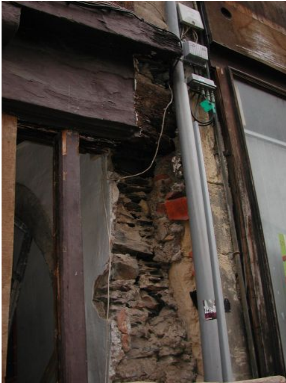
Boutique, angle supérieur droit après suppression du poteau-cornier, pendant les travaux d'octobre 2002.
