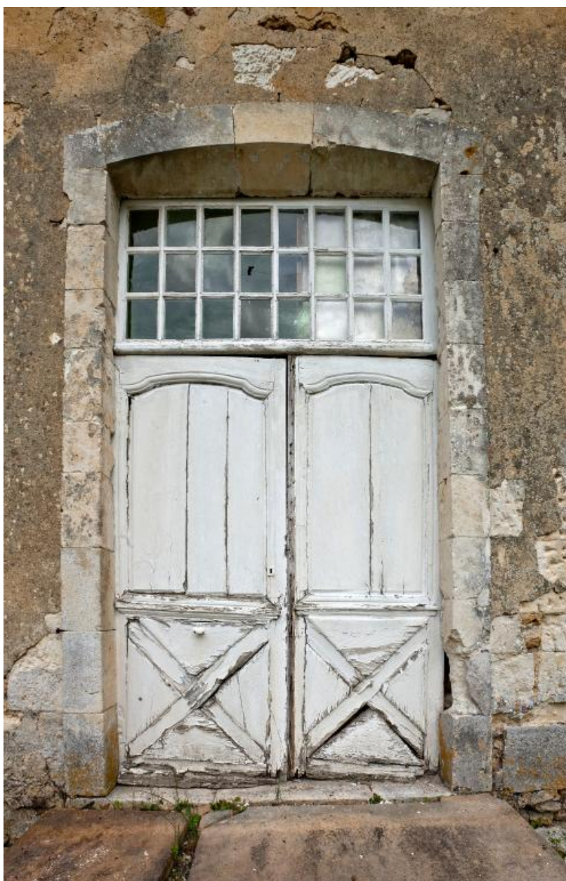
Maison de maître, façade antérieure sur cour : porte d'entrée.
