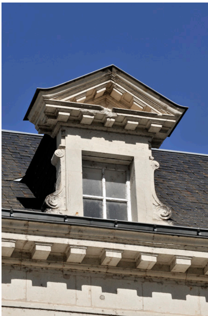
Façade principale, au sud : détail de la lucarne est.
