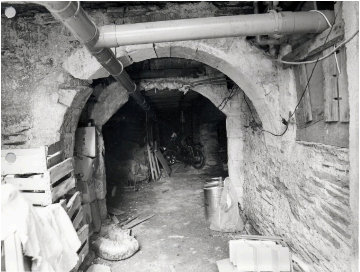
Accès à la cave, depuis la cour.
