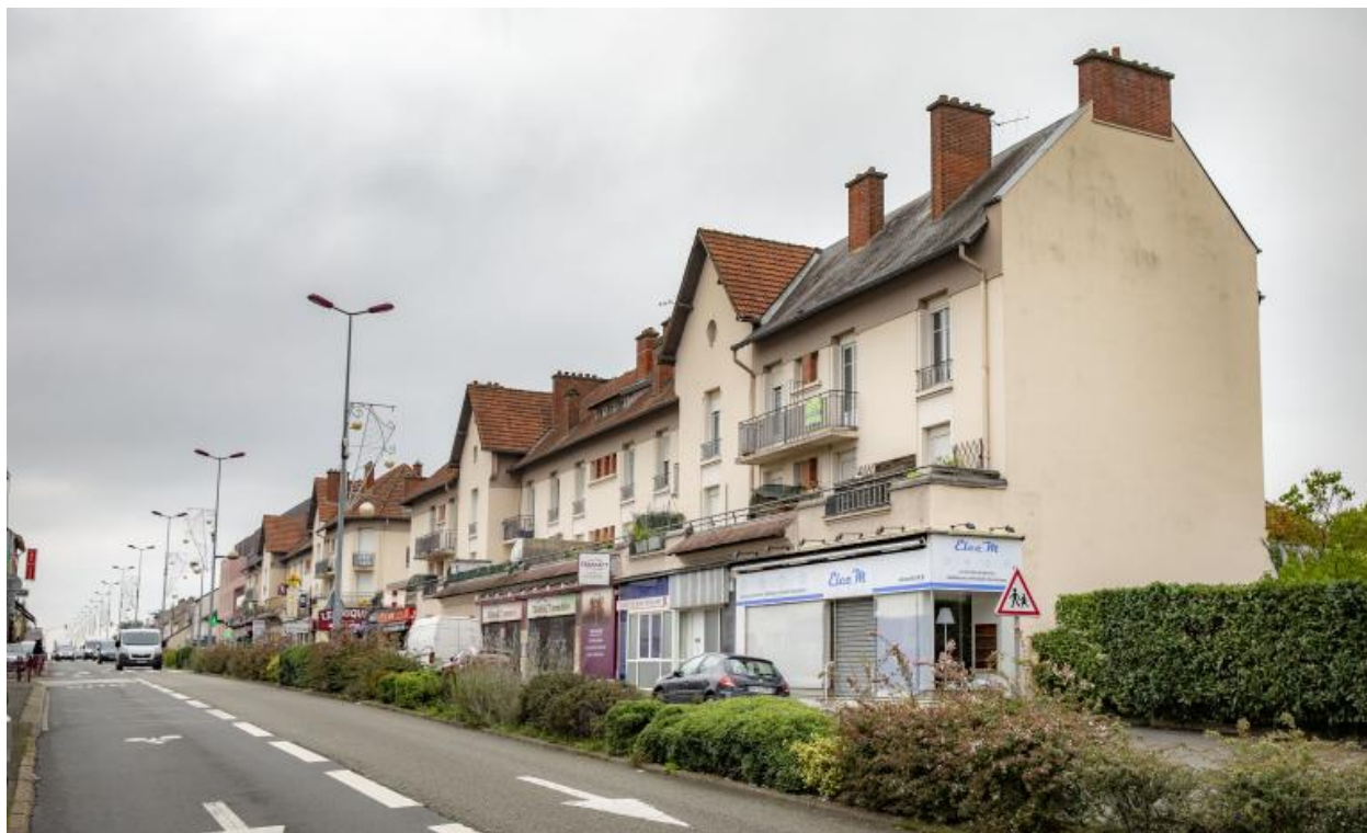
Vue des immeubles côté rue de l'avenue Felix Geneslay.
