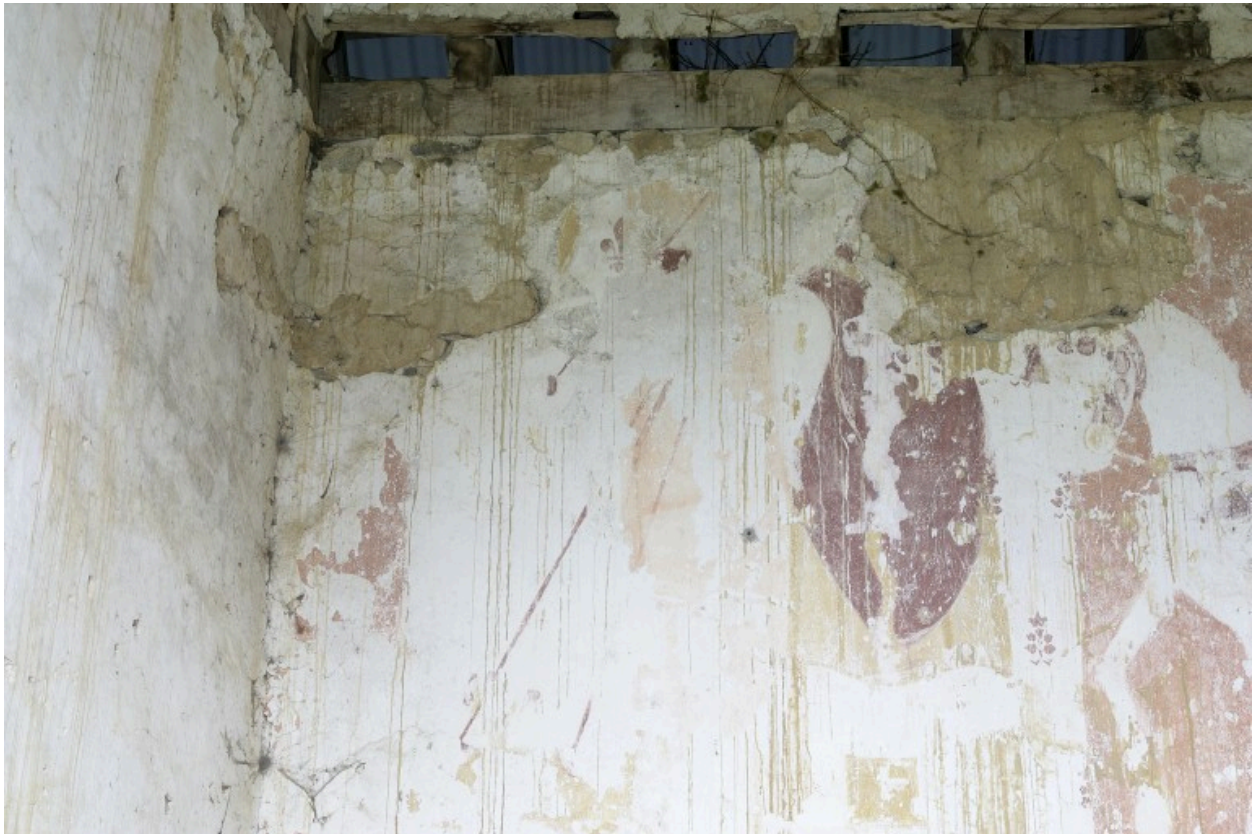
Mur nord, partie gauche et médiane.
