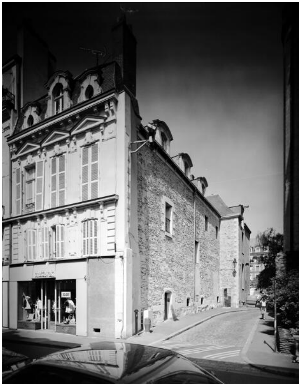
Second logis abbatial : vue de situation au nord-est, depuis la rue des Lices.
