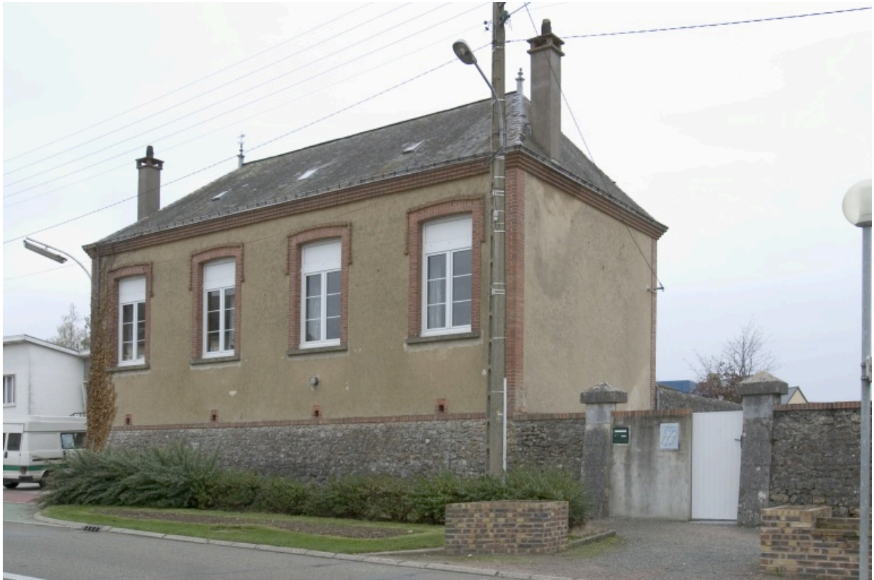
Vue depuis la route au nord.
