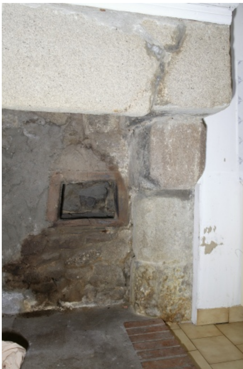
Détail de la cheminée est au rez-de-chaussée.
