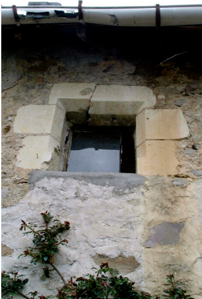
Détail d'un jour sur le mur gouttereau sud.
