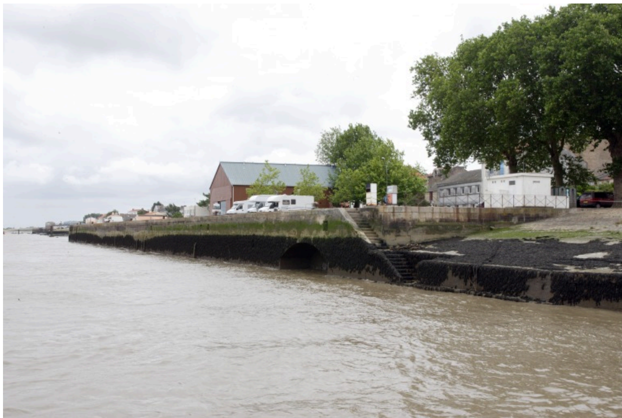
Le quai Sadi-Carnot vers l'amont.
