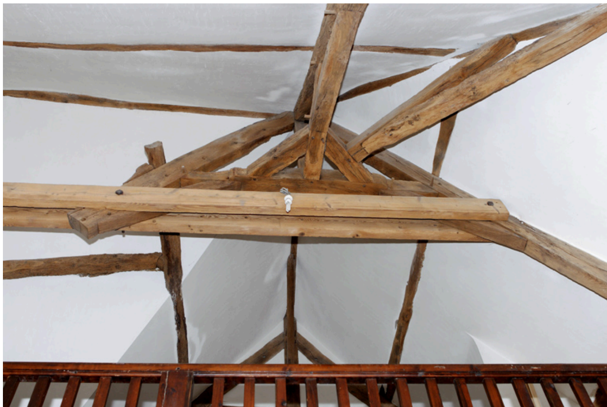
Logis. Aile sud. Détail de la charpente.
