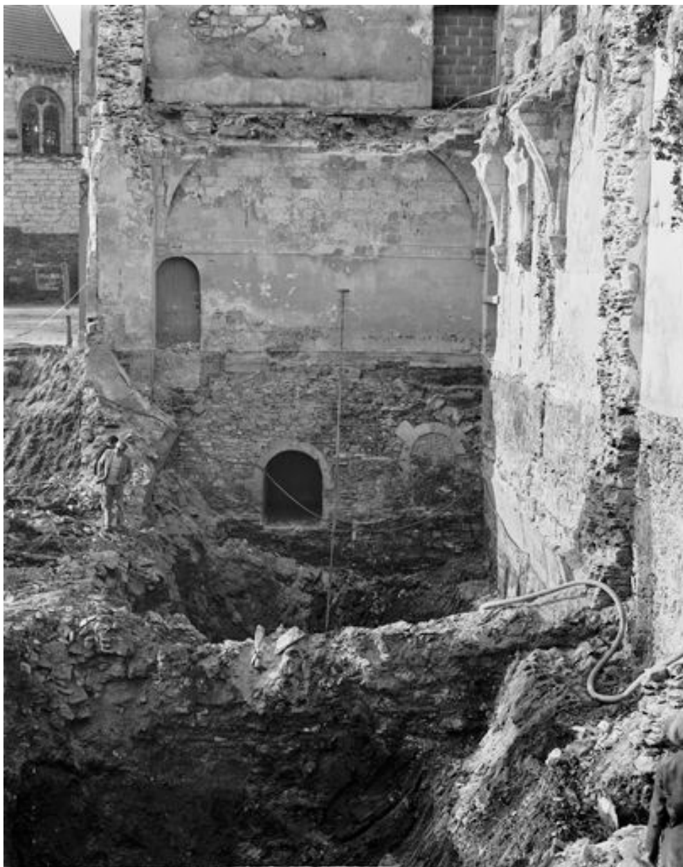
Aile de la cuisine, vestige : élévation intérieure ouest du rez-de-chaussée et du sous sol. Etat lors du chantier de la bibliothèque.
