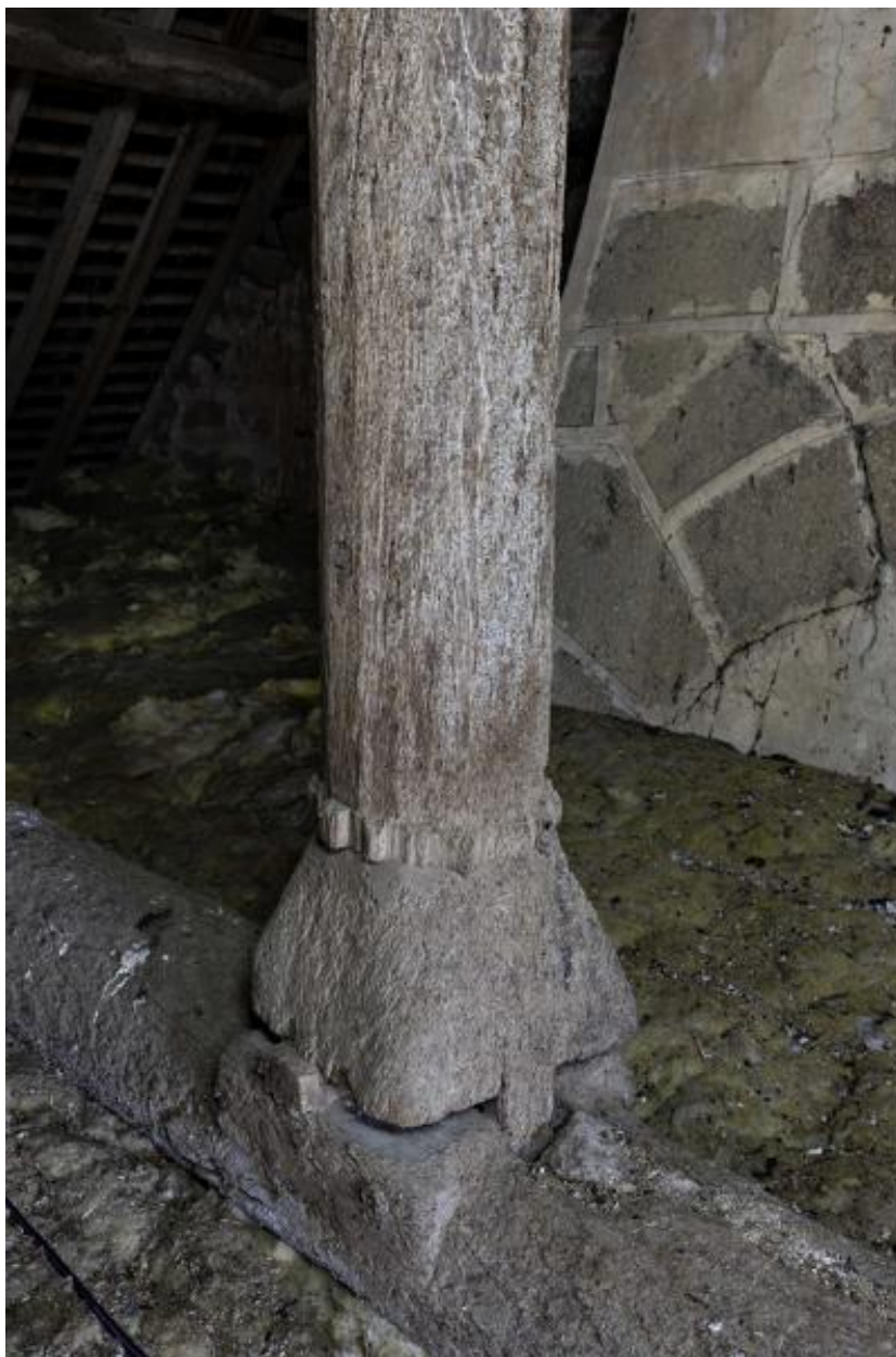
Charpente. Détail de la base du poinçon.
