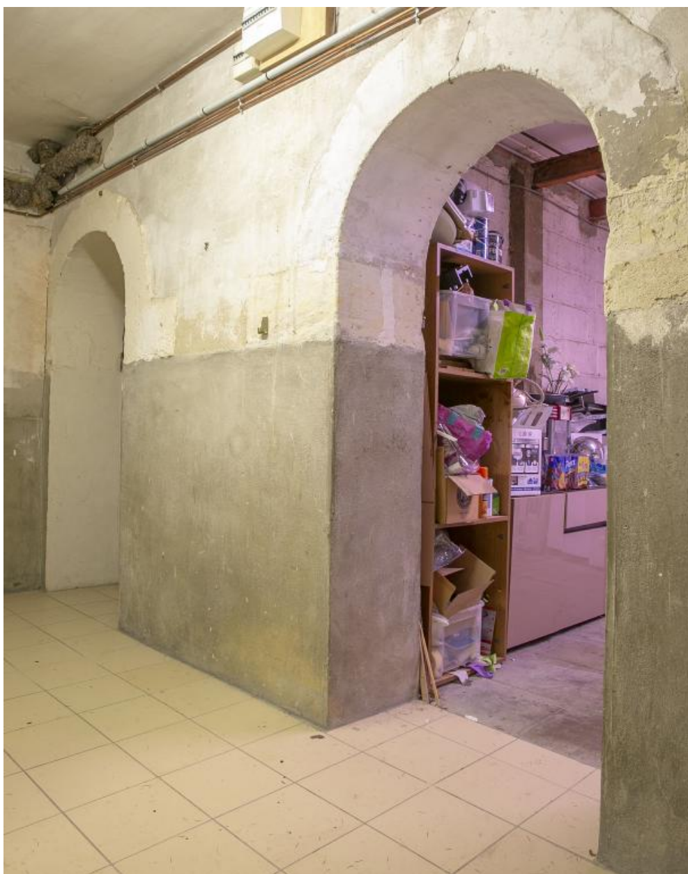
Vue du sous-sol.
