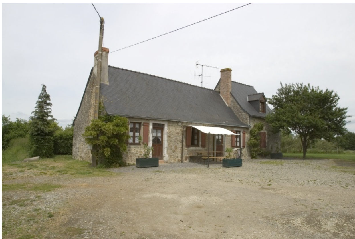
La façade principale du logis.
