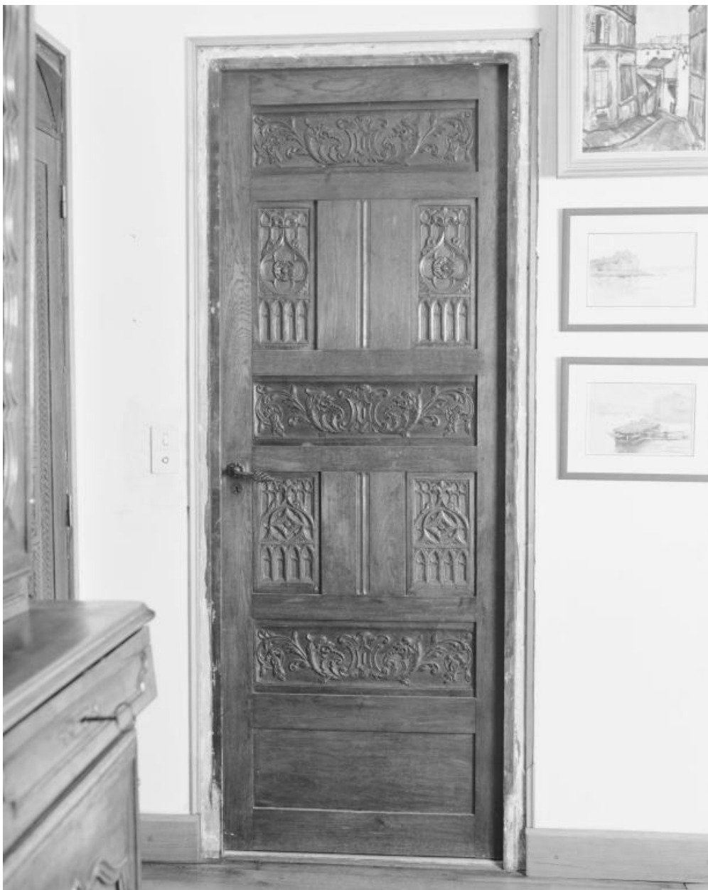
Porte intérieure de la villa Kenavo.
