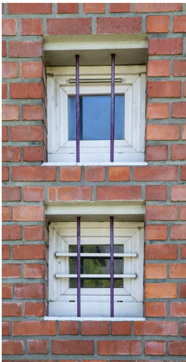
Détail des ouvertures de service du bâtiment B1 depuis la rue des Maillets.
