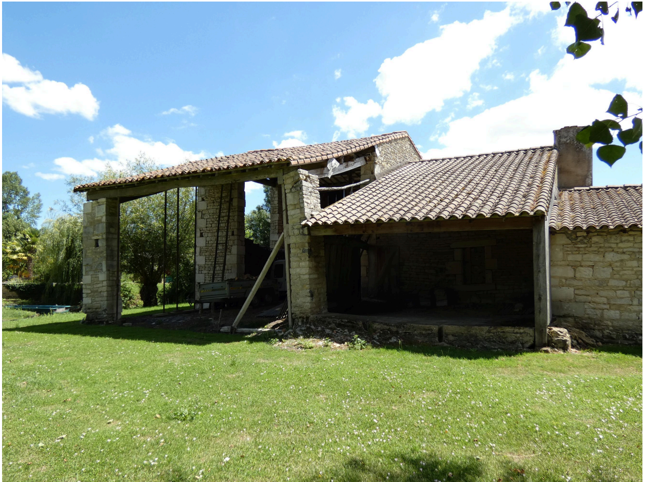
Le hangar, à l'est des dépendances, vu depuis le nord-ouest.
