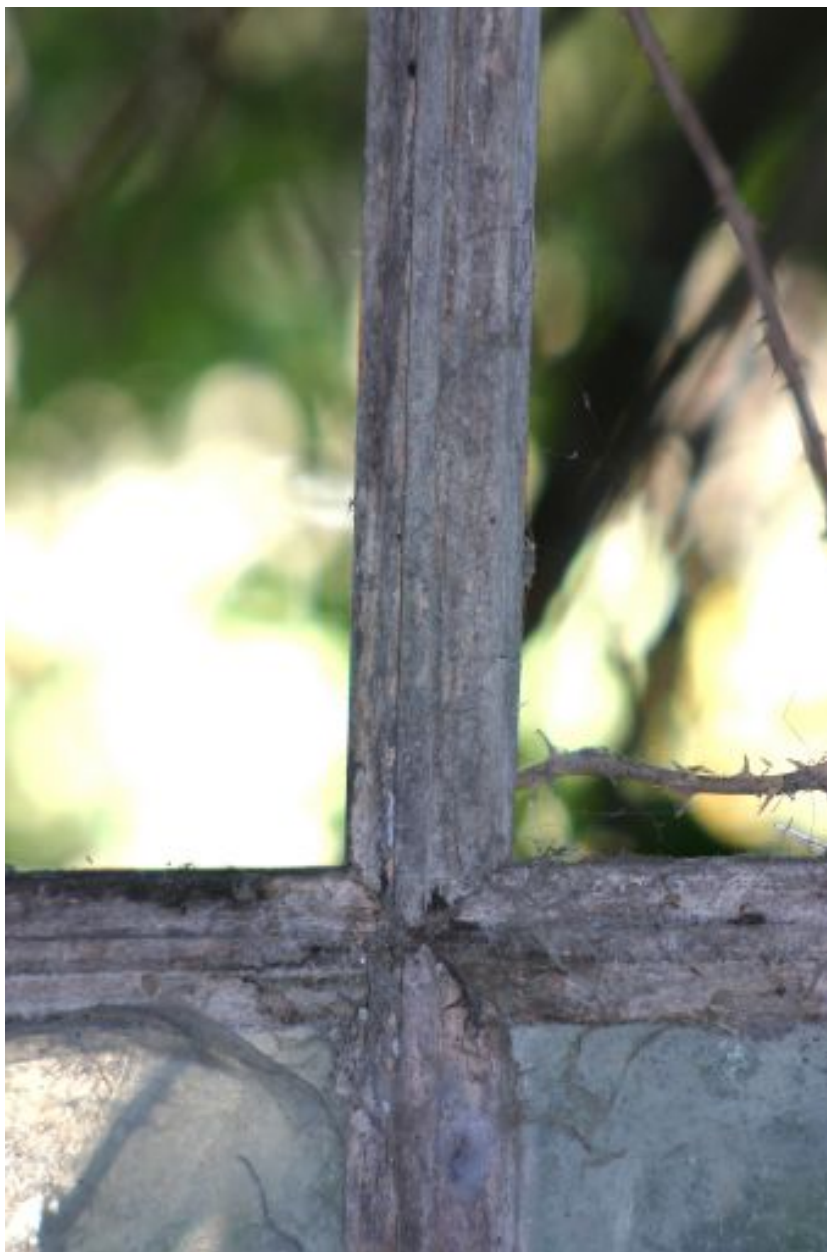
Menuiserie de baie : face extérieure.
