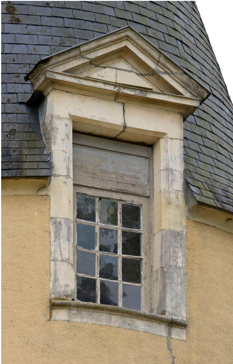
Fenêtre passante de lucarne de la tour ouest du logis.
