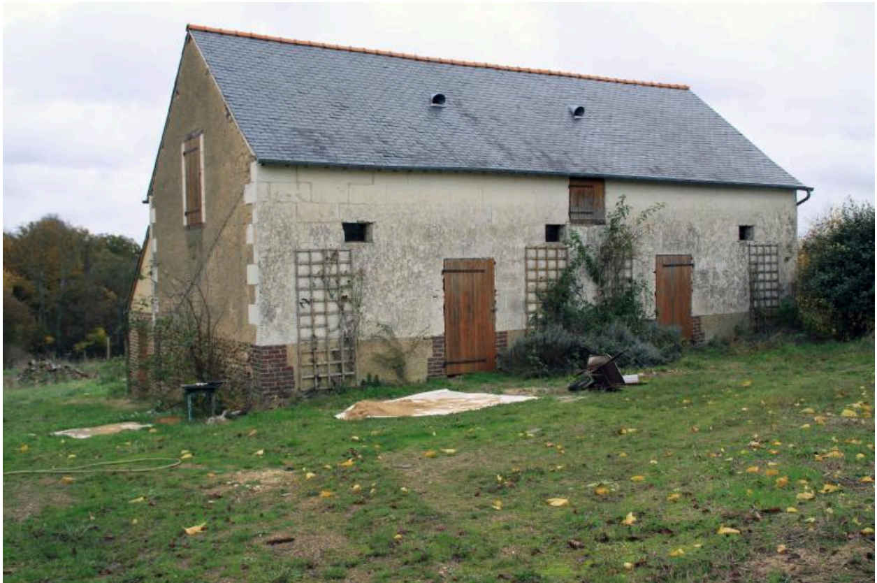
Grange-étable : façade antérieure en pierre de taille de grand appareil sur solin de brique.
