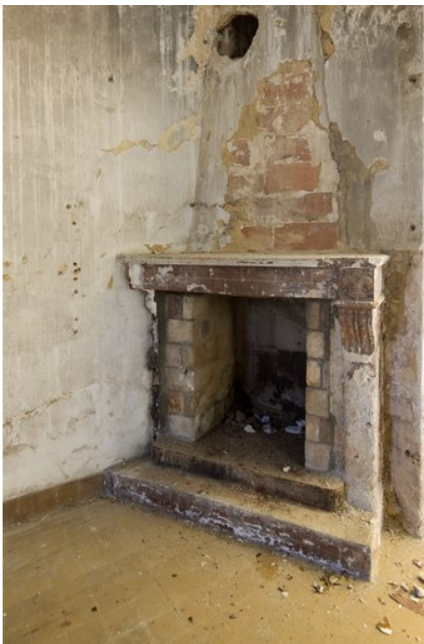
Cheminée du petit bâtiment à l'est du pavillon d'entrée.
