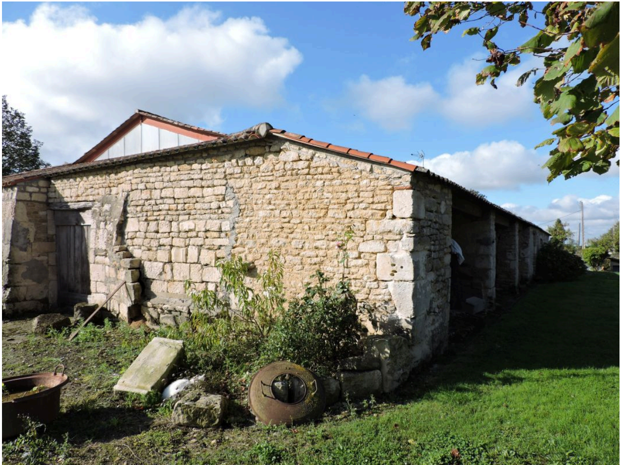
Les dépendances vues depuis le nord-est.
