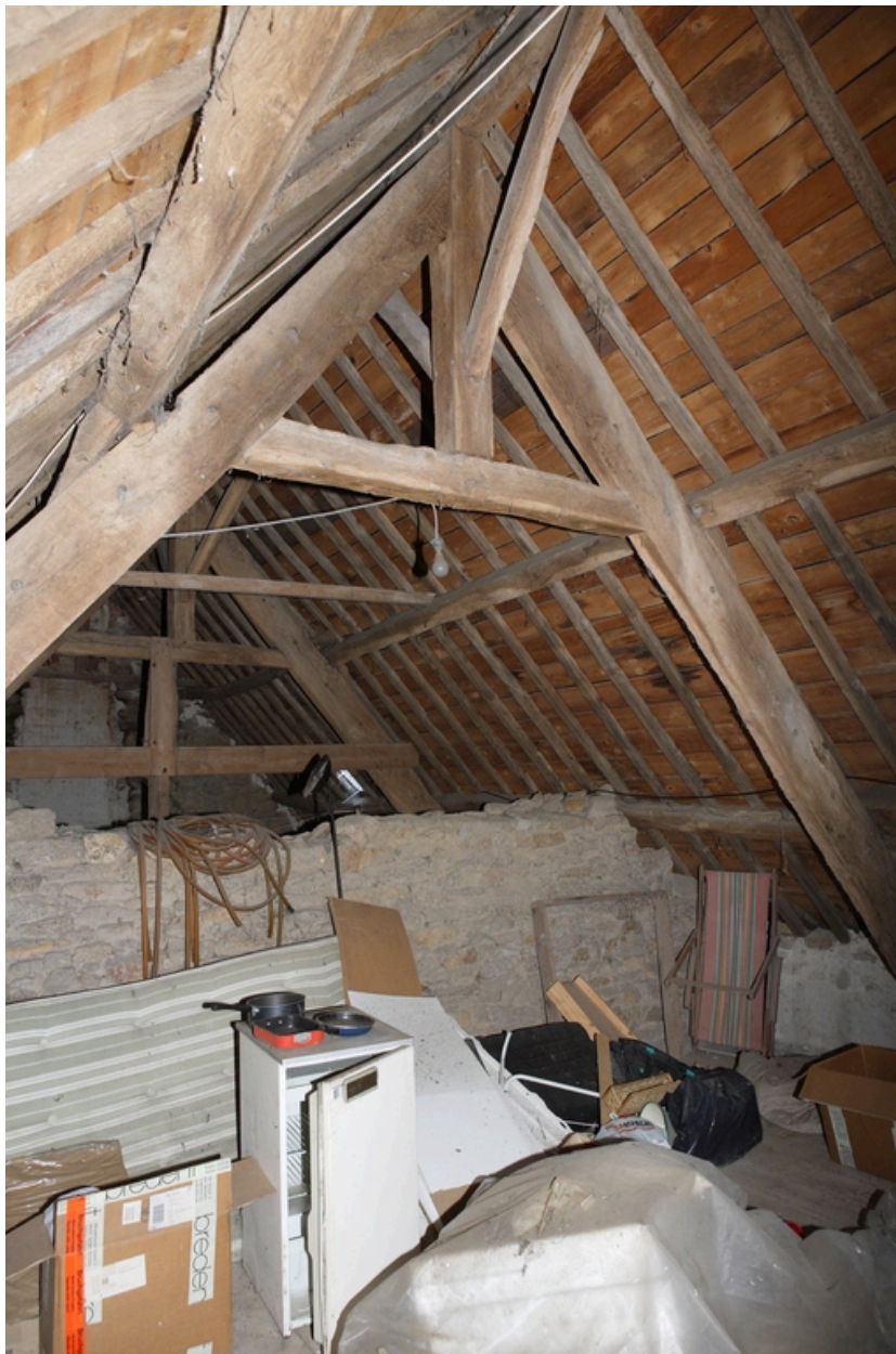
Vue de la charpente du n° 9 rue du Rocher.
