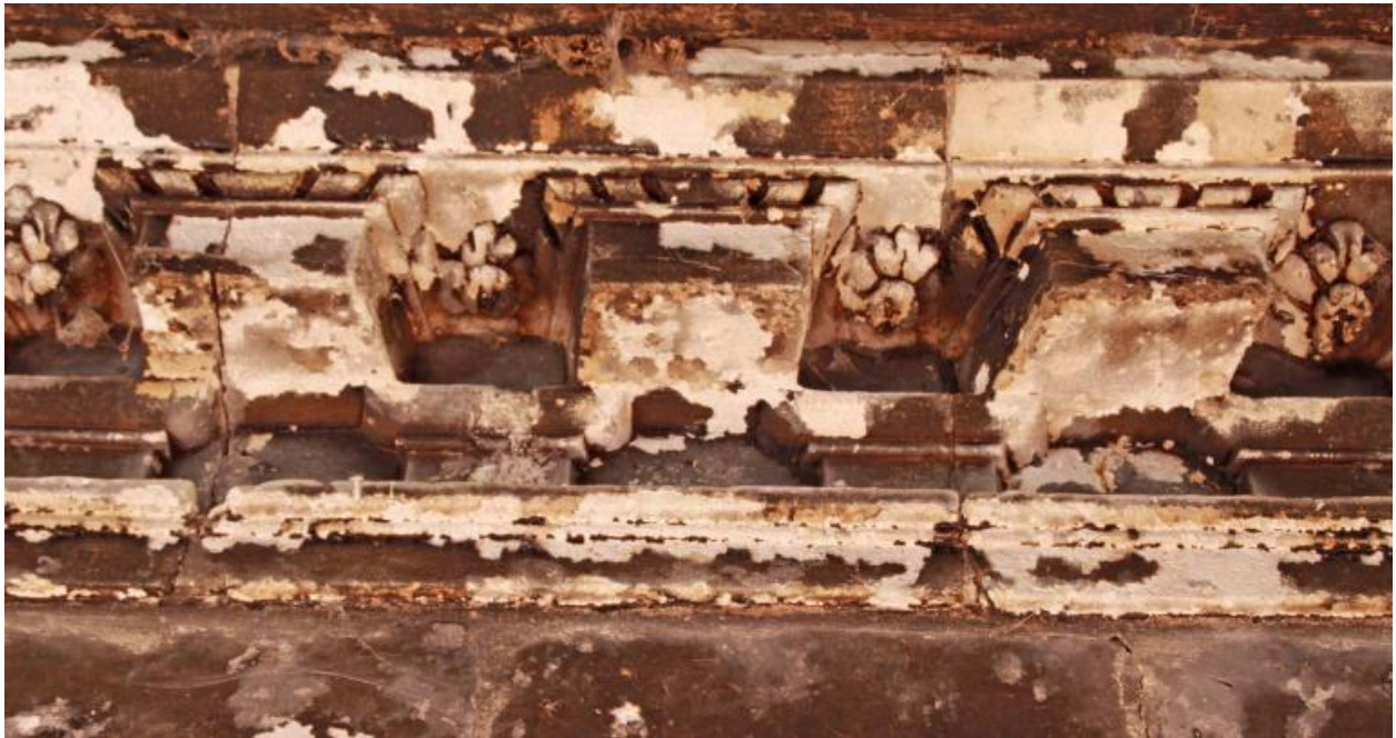
Pavillon, étage, cheminée : détail décor de la corniche.
