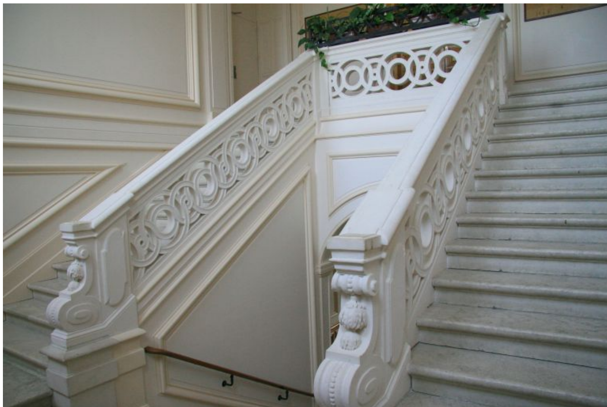
Escalier monumental avec deux volées parallèles.
