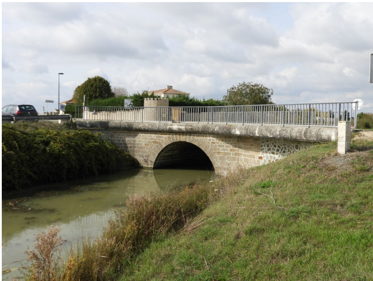
Le pont vu depuis le sud-est, côté aval.
