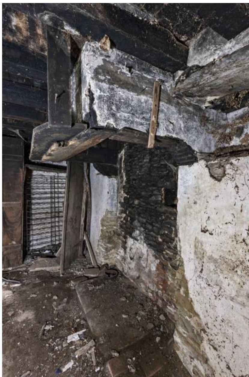
Cheminée du mur-pignon occidental.
