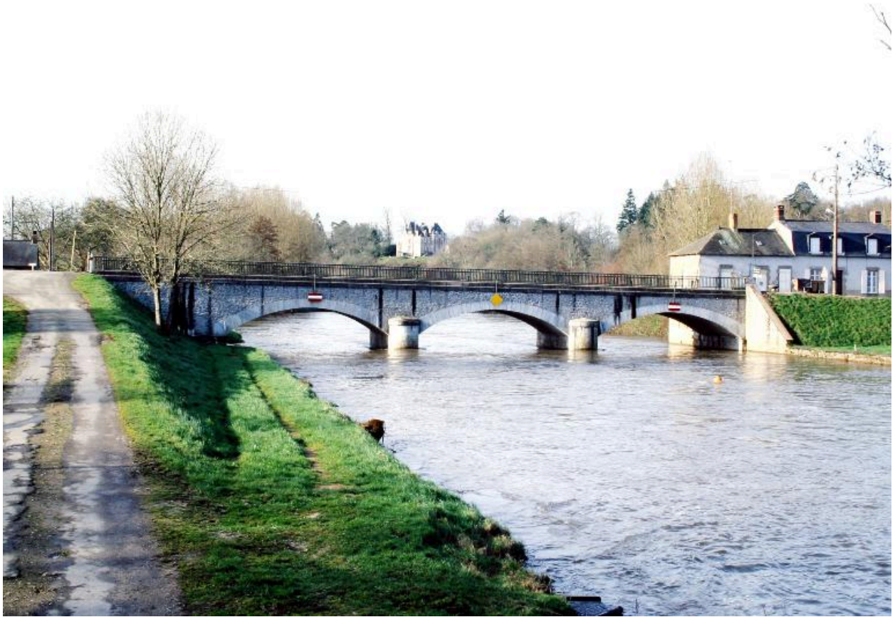
Le pont vu depuis la rive gauche en amont. Au fond, le château de Montgiroux.
