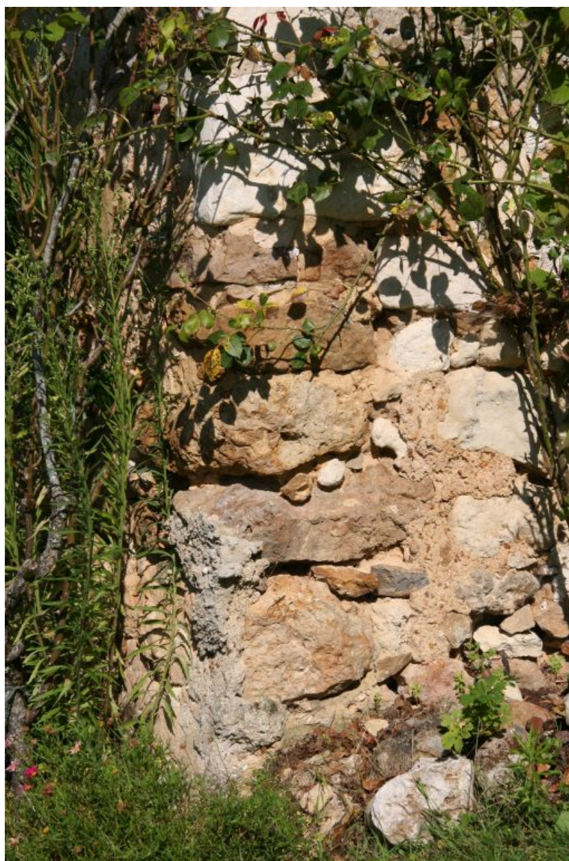
Angle de la maison de blocs de silex.
