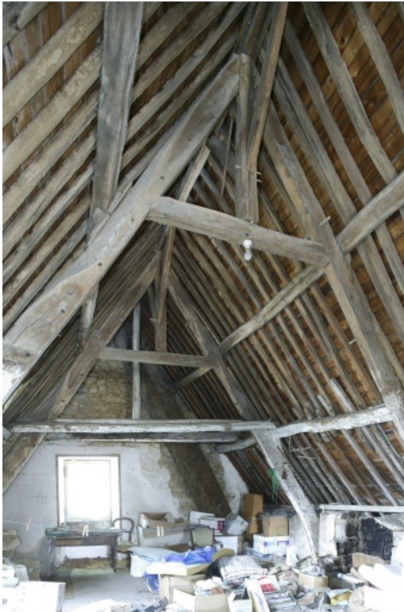
Charpente vue vers le Nord.
