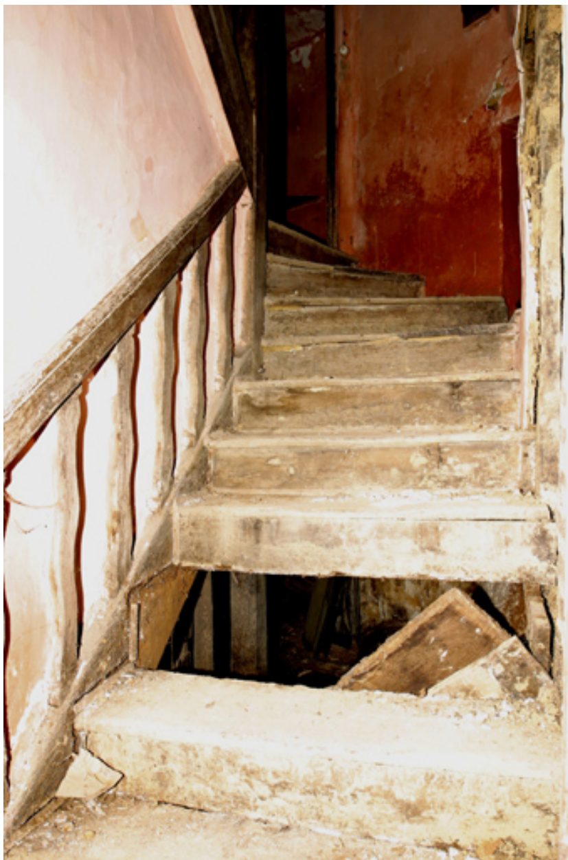
Escalier dans la salle est de l'aile nord.
