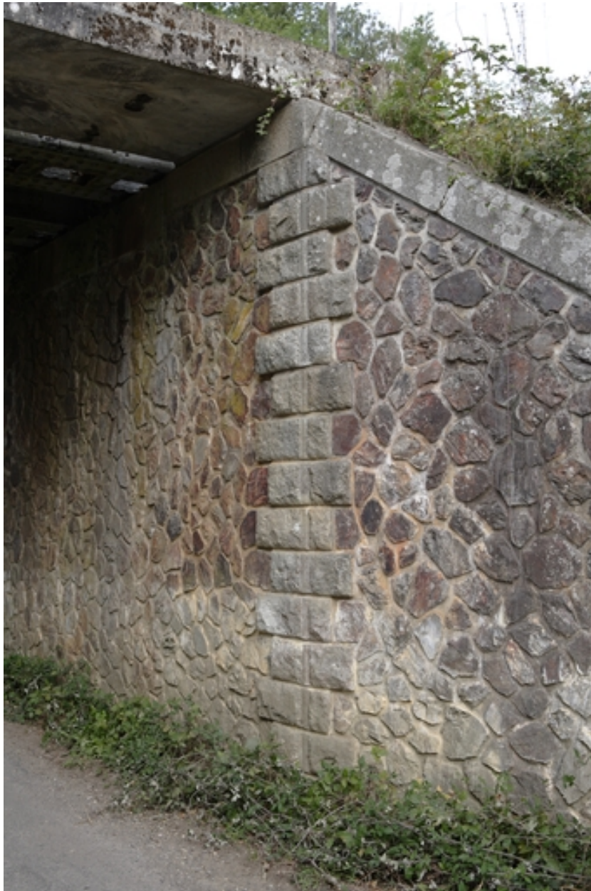
Détail de la maçonnerie et du chaînage d'angle.
