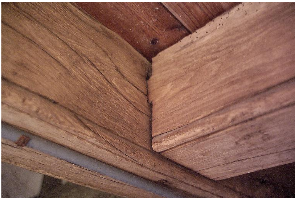
Le corps en appentis situé au sud, détail des solives.
