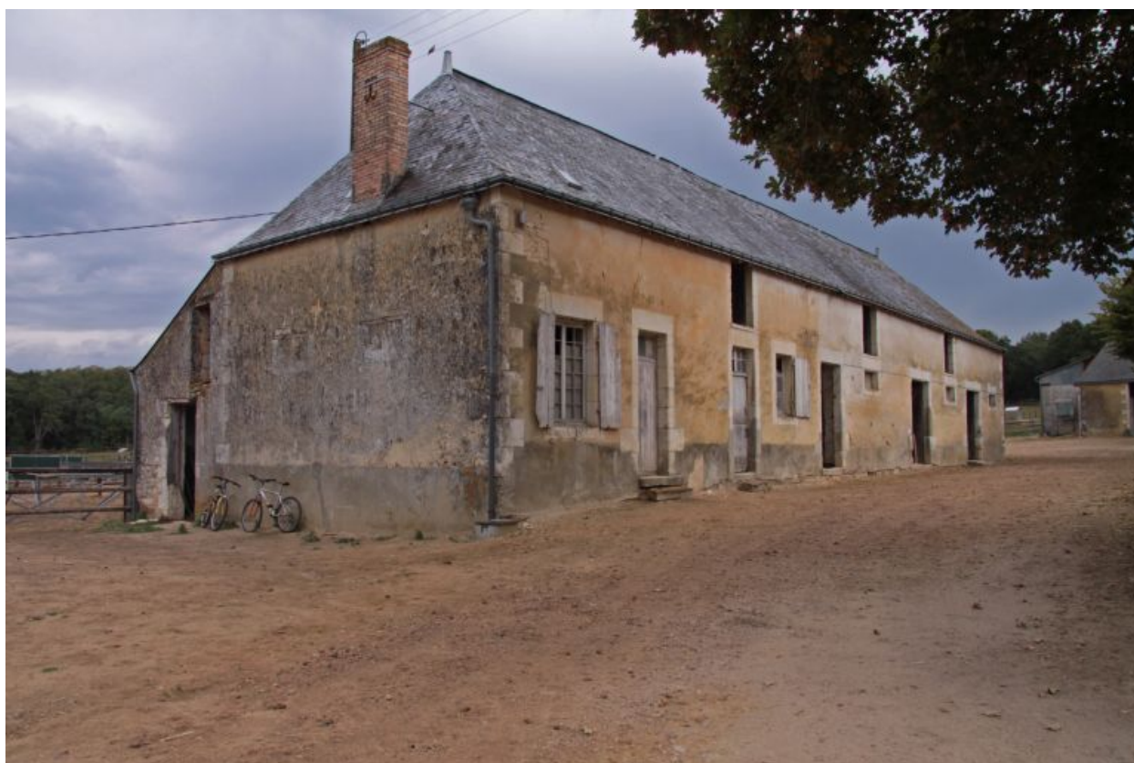
Aile ouest des communs.
